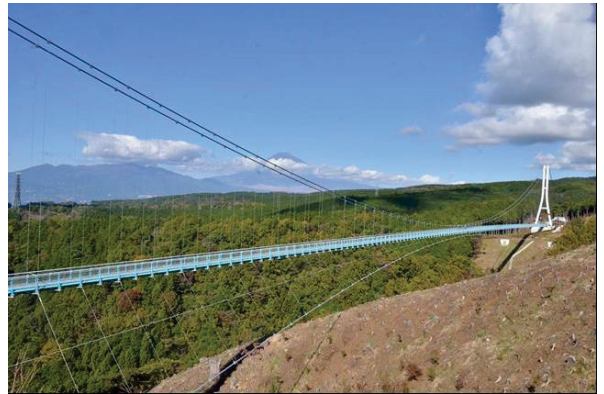
写真 1-12 箱根西麓・三島大吊橋
