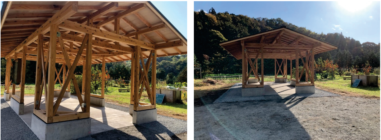
写真 1-9 山田川自然の里「休憩施設」(県産材 80%以上使用)
