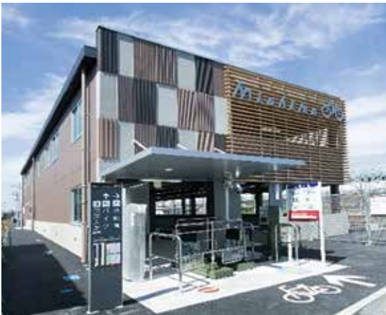
▼三島駅南口自転車等駐車場
