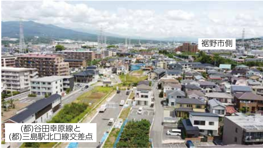
◀ (都)三島駅北口線の様子
