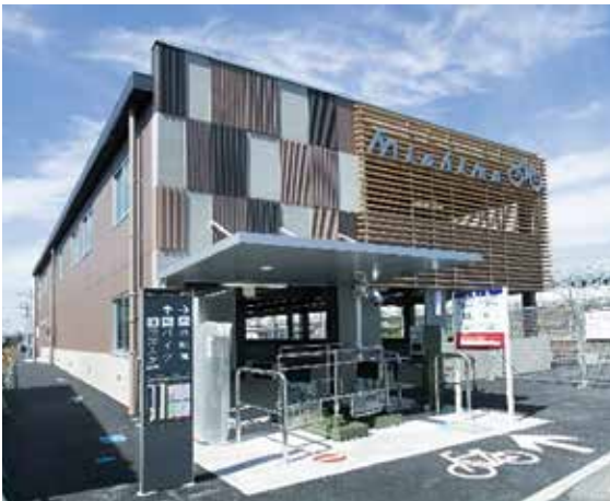
▼三島駅南口自転車等駐車場
