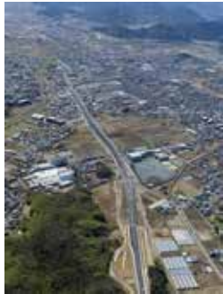
◀ (都) 東駿河湾環状線の大場・函南インターチェンジ付近の様子
