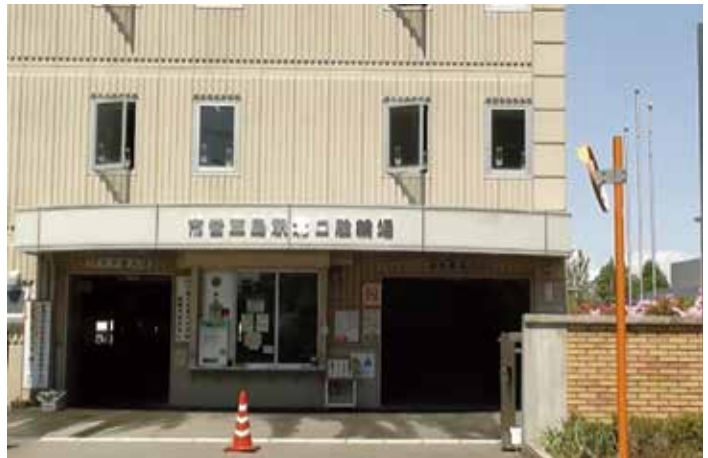
▼三島駅北口自転車等駐車場
