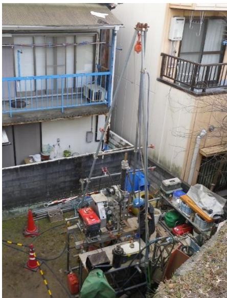
No.1の掘削状況
