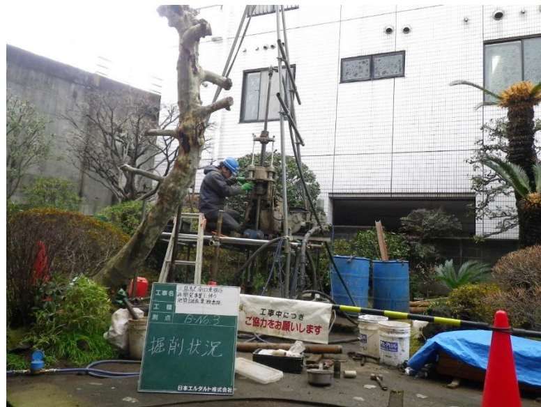
No.3の掘削状況
