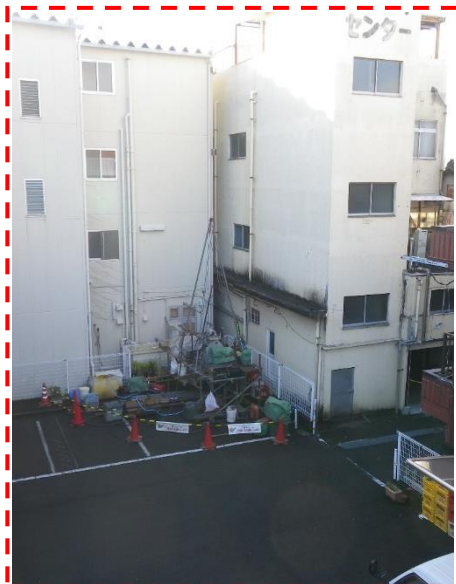
No.2の掘削状況
