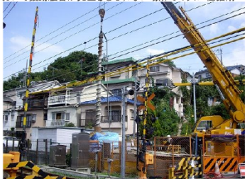
住宅・鉄道近接部でのサイクルハンマー施工状況
