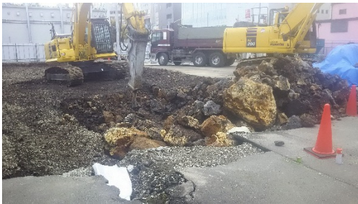
②基礎岩盤掘削開始
