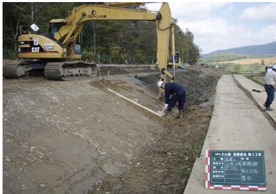
斜面(法面)を造る
