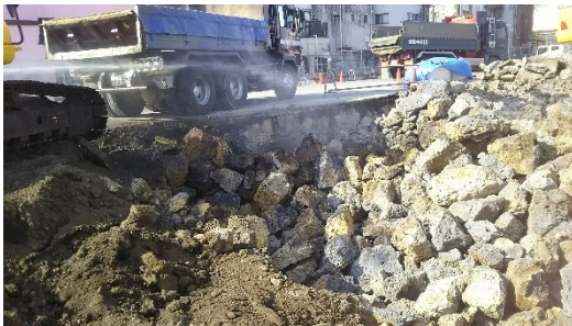
③基礎岩盤掘削
