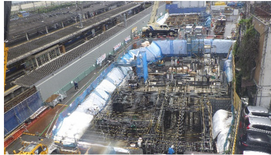
④西側基礎工事
