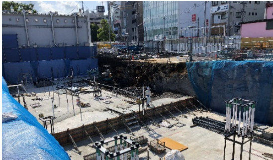
①鉄骨アンカーセット(東側基礎)
