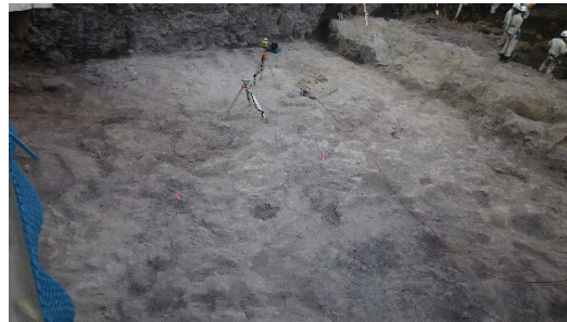
⑥溶岩掘削床付面状況
