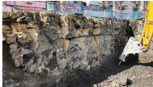
④岩盤掘削法面(溶岩自立)
