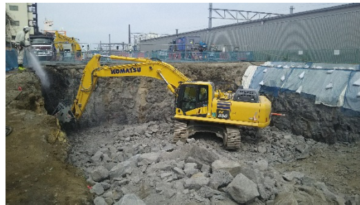
⑤基礎岩盤掘削
