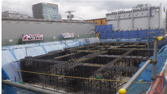
②基礎配筋(東側基礎)
