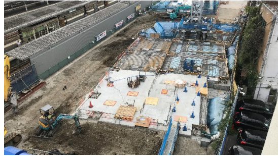
⑤西側1階床工事
