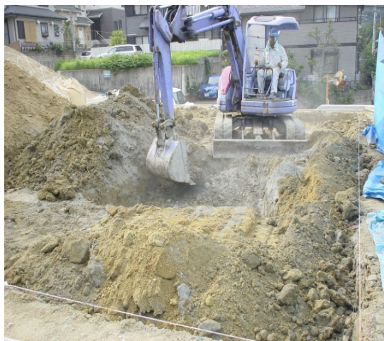
地盤改良(粉体)
