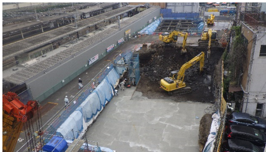
③西側掘削
