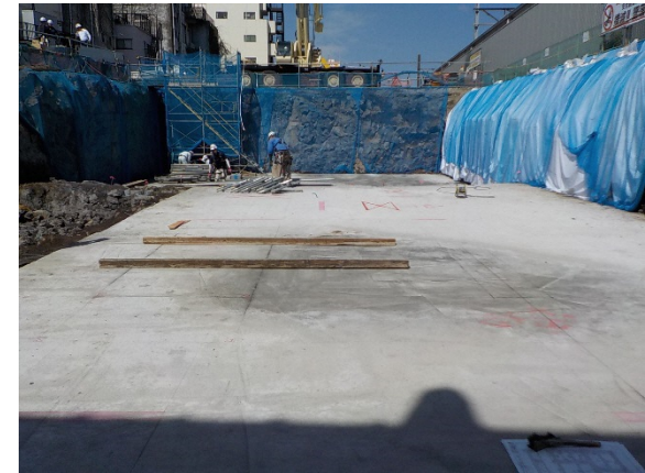
⑦レベルコンクリート打完了
