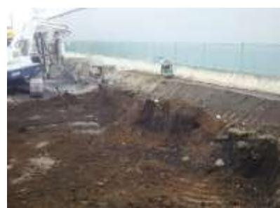
図 地盤改良及びオープンカットの状況
