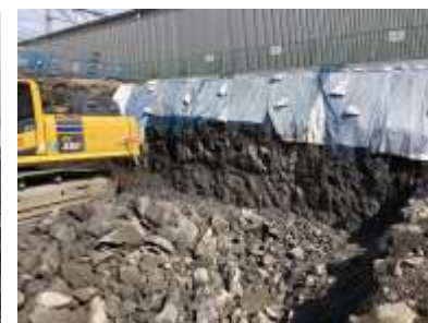
図 降雨時の対策(養生の状況)
