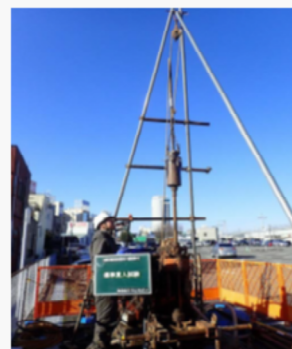
△ボーリング調査の様子
