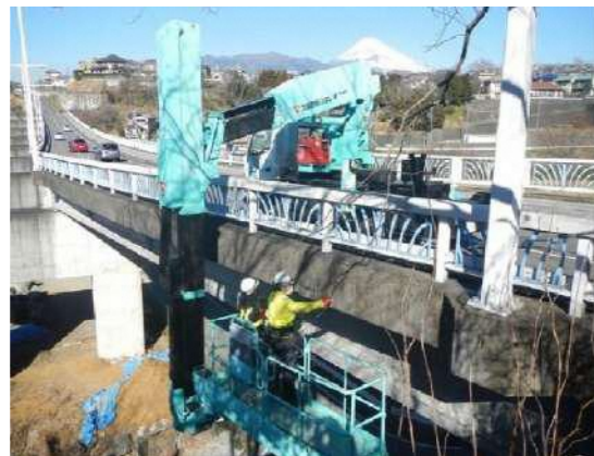
点検車による点検
