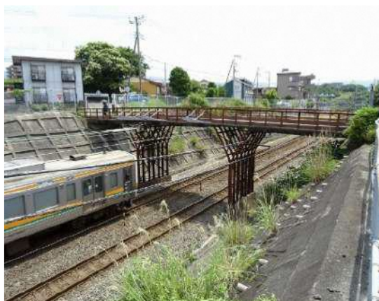
天神原跨線橋（加茂川町）
