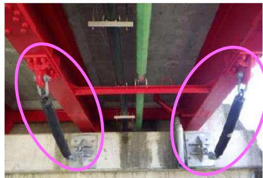
落橋防止工事例
