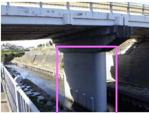
橋脚柱耐震補強例
