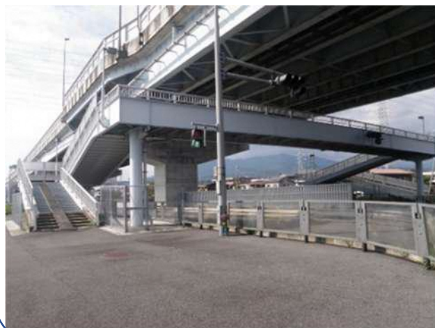
萩西横断歩道橋
