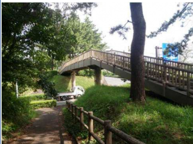
初音ヶ原歩道橋
