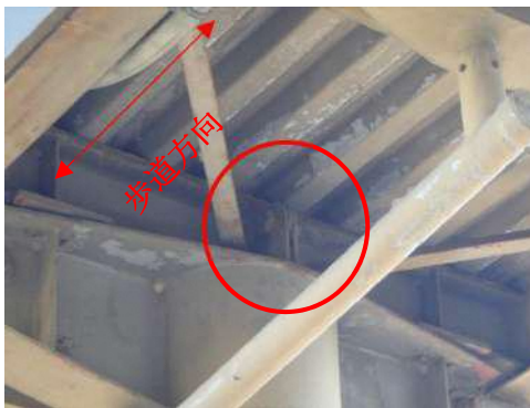
歩道方向の対策事例 (初音ヶ原歩道橋)
