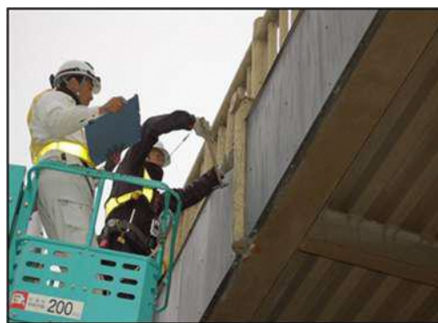
近接目視、打音検査による点検
