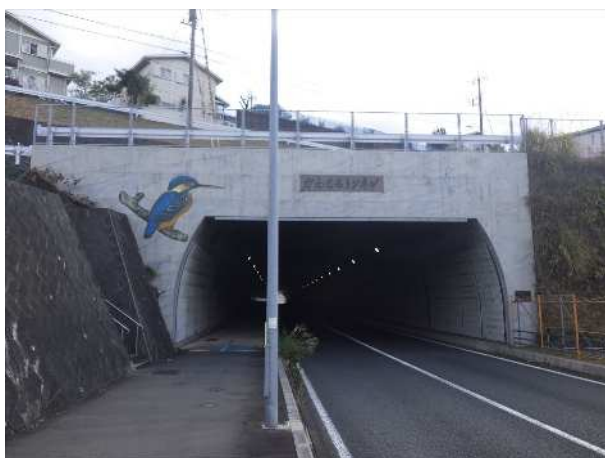
壱町田 6 号線ボックスカルバート
