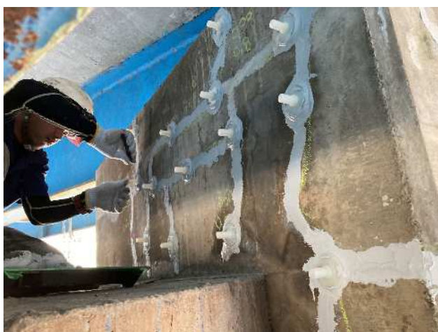
注入器具の設置状況
