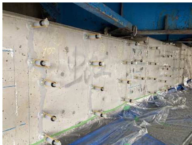
充填材注入状況
