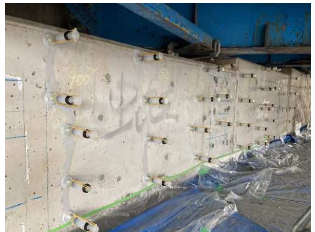
充填材注入状況
