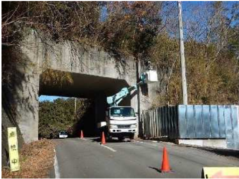
高所作業車を用いた点検
