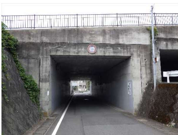
谷田幸原線ボックスカルバート (2)
