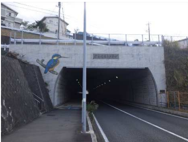
吉町田6号線ボックスカルバート
