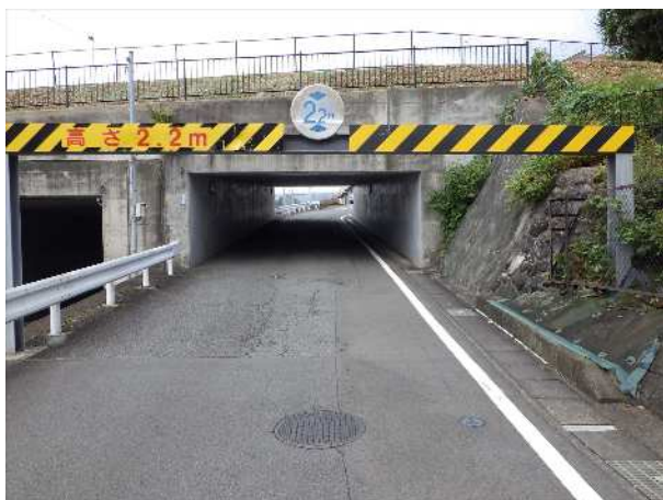
谷田幸原線ボックスカルバート (1)
