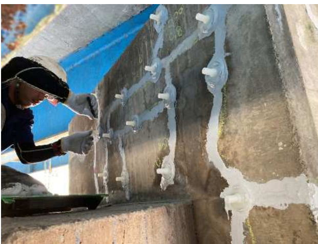
注入器具の設置状況
