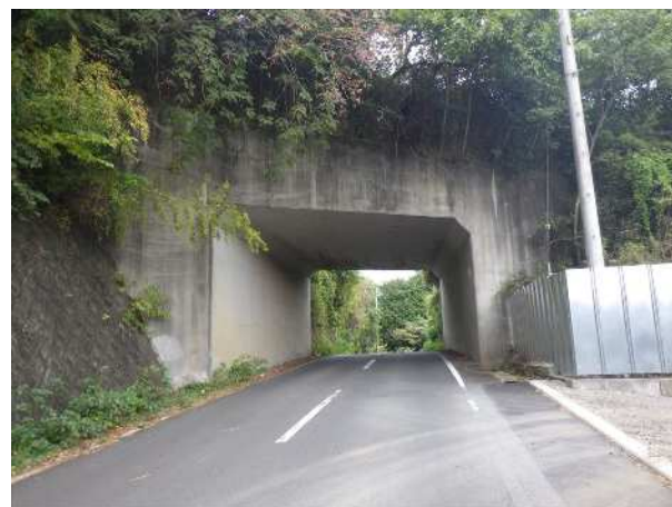
三島2号線ボックスカルバート
