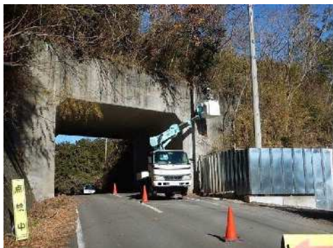
高所作業車を用いた点検
