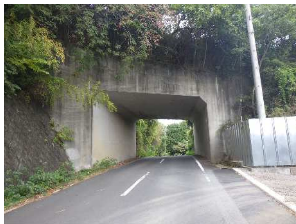
三島 2 号線ボックスカルバート
