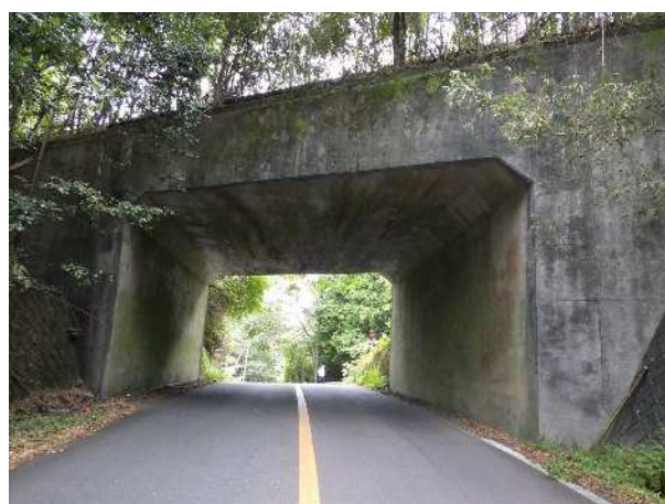
上沢地片平山線ボックスカルバート
