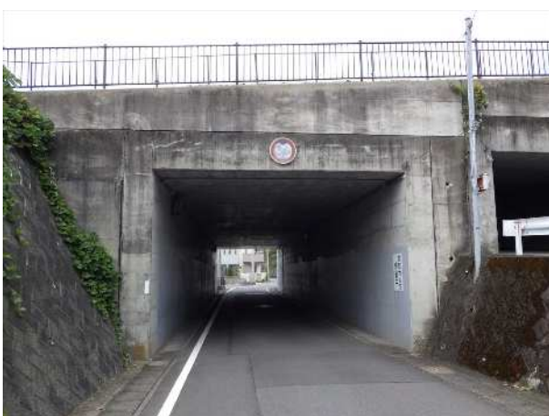
谷田幸原線ボックスカルバート(2)
