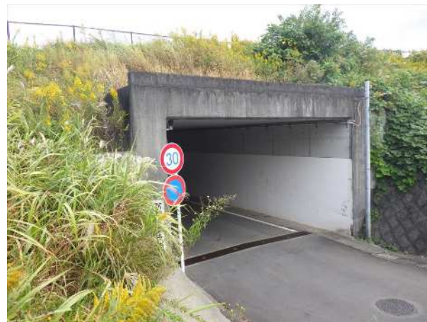
谷田幸原線ボックスカルバート(3)
