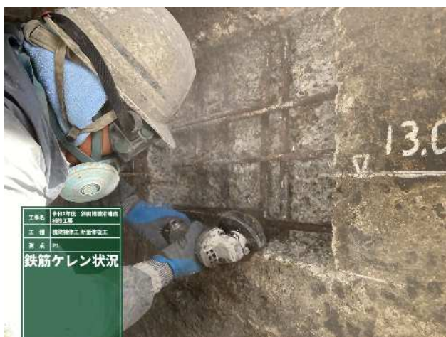
鉄筋ケレン（錆の除去）状況
