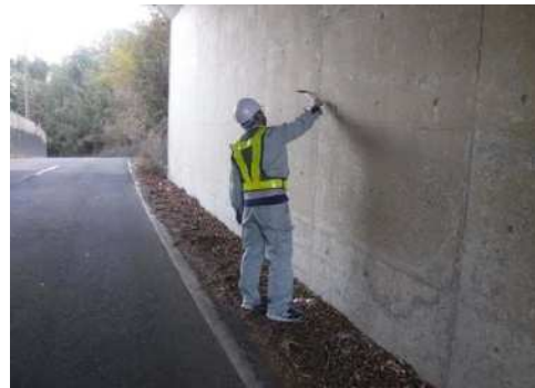
打音検査を行う近接目視点検
