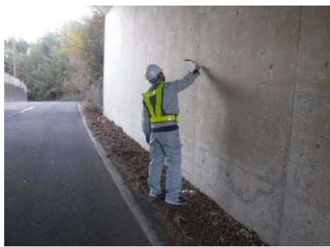
打音検査を行う近接目視点検
