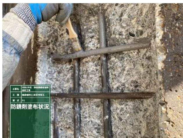
防錆剤塗布状況
