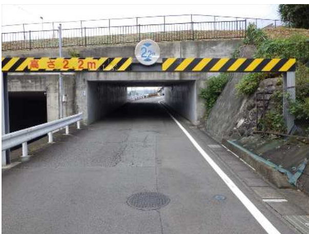
谷田幸原線ボックスカルバート(1)
