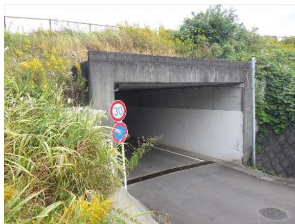
谷田幸原線ボックスカルバート (3)
