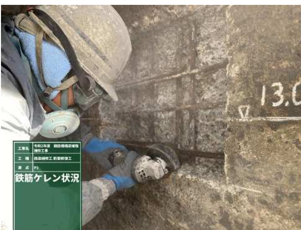
鉄筋ケレン（錆の除去）状況
