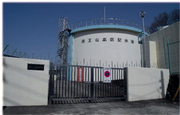
赤王山高区配水場
