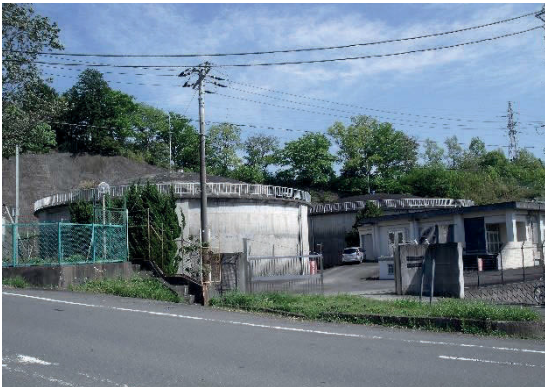
北沢低区配水場
