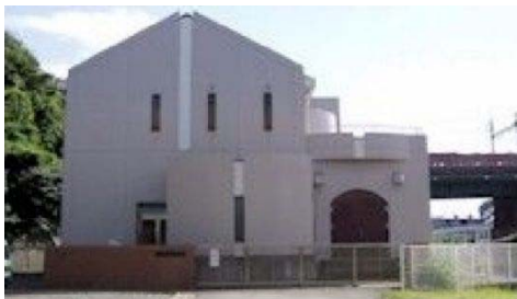
吉町田汚水中継ポンプ場（加茂川町）
