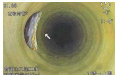
改築実施後（管の内側に樹脂を施工）
