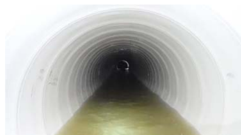
耐震化実施後
