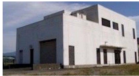
南部汚水中継ポンプ場（中）
