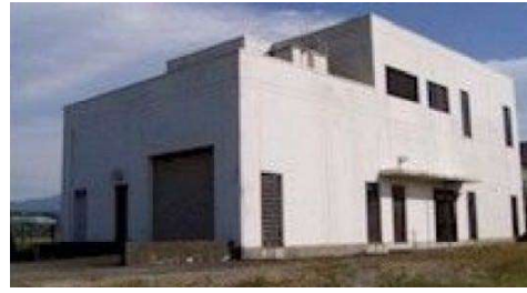
南部汚水中継ポンプ場（中）
