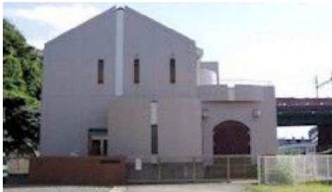
吉町田汚水中継ポンプ場（加茂川町）
