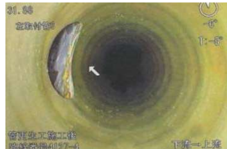
改築実施後（管の内側に樹脂を施工）
