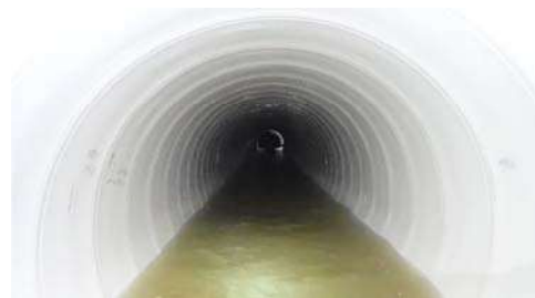
耐震化実施後
