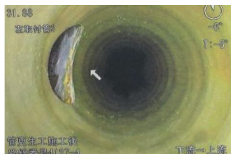
改築実施後（管の内側に樹脂を施工）
