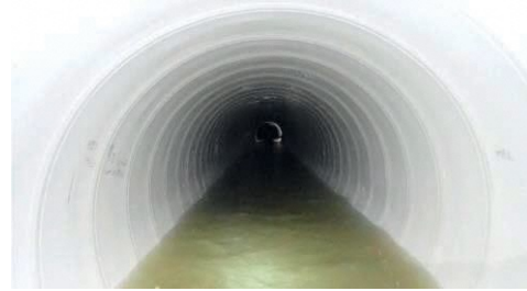
耐震化実施後
