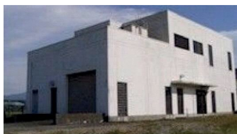
南部污水中継ポンプ場（中）
