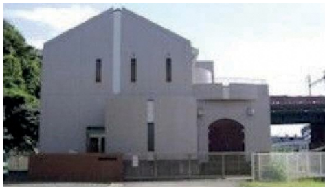
壱町田污水中継ポンプ場（加茂川町）
