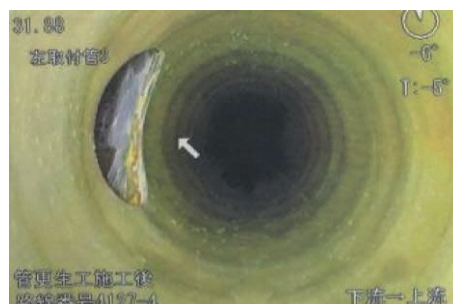
改築実施後（管の内側に樹脂を施工）
