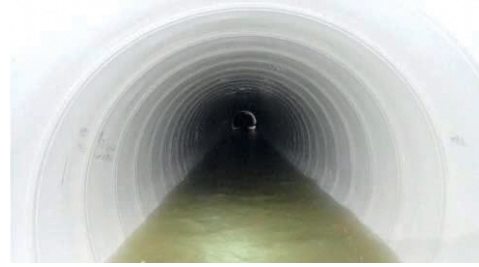
耐震化実施後
