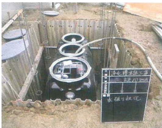
【写真 4】据付工事の状況を示す写真
