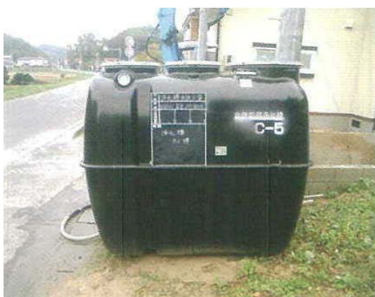
【写真 3】浄化槽本体の写真
