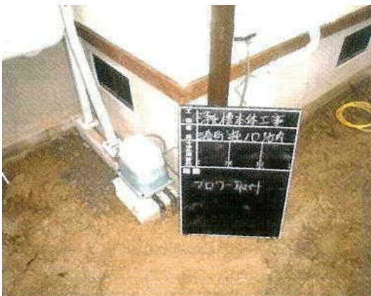
【写真7】ブローア設置状況を示す写真
