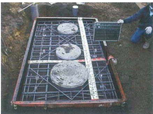
【写真6】上部スラブ工事を示す写真
