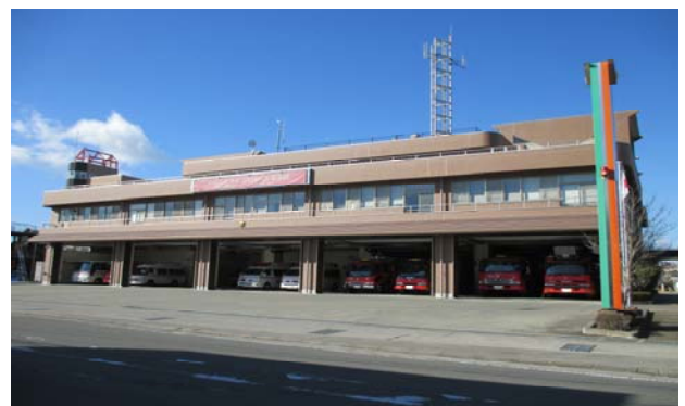
消防庁舎（消防本部・消防署）
