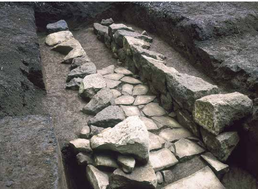
村上石橋(基礎部分)
