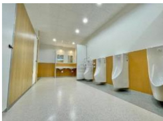
▲山田中学校（トイレ改修）
