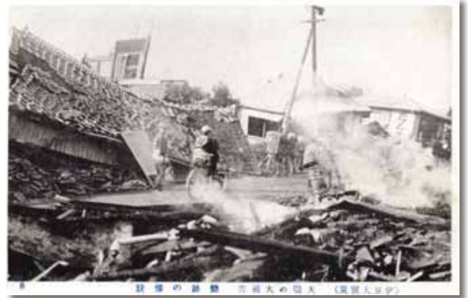
「(伊豆大震災) 大場の大被害 焼跡の惨状」
