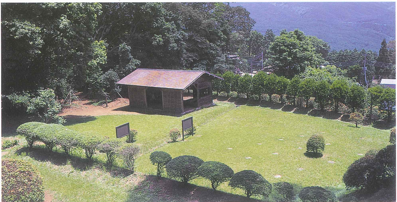
兵糧庫の礎石と復元休憩舎
