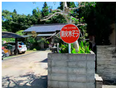
防災施設（防火水槽）
