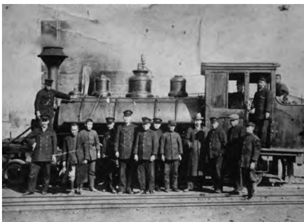
図 2-28 軽便鉄道として開業した豆相鉄道 現在の伊豆箱根鉄道駿豆線。当初は三島(現下土狩駅)～南条(現伊豆長岡)で営業していた。
