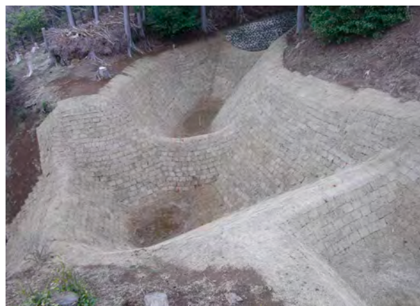
図 3-20 二ノ丸西堀 再整備中
