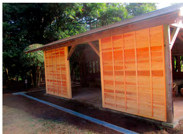
図 3-22 兵糧庫休憩所 再整備後
