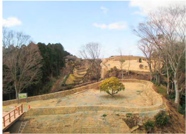
図 3-14 元西櫓 再整備中
