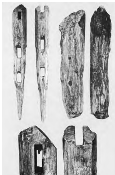
図 3-50 柱材、梁材と細部のようす
