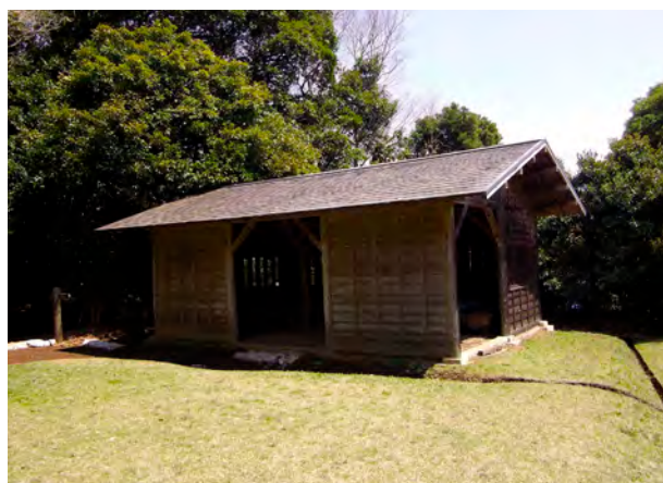
図 3-21 兵糧庫休憩所 再整備前
