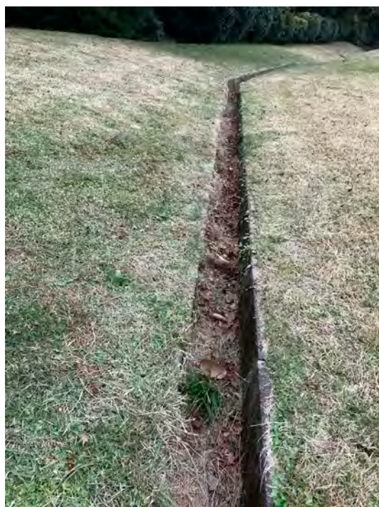
図 9-19 岱崎出丸の排水溝
