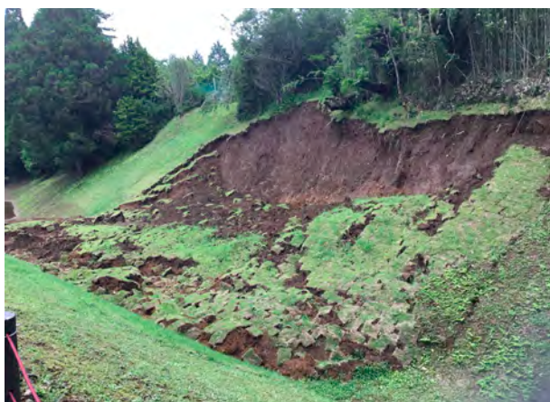
図 9-11 令和3年再被災 1 三ノ丸西堀
