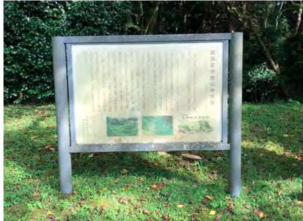
図 5-8 表面が劣化して読みにくくなった説明板
