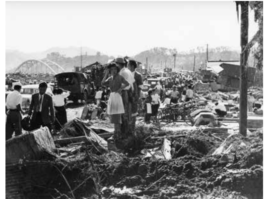
昭和33年狩野川台風の被害(狩野川資料館所蔵)
