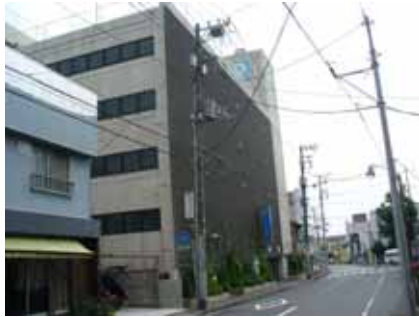
(三島市営中央駐車場)
