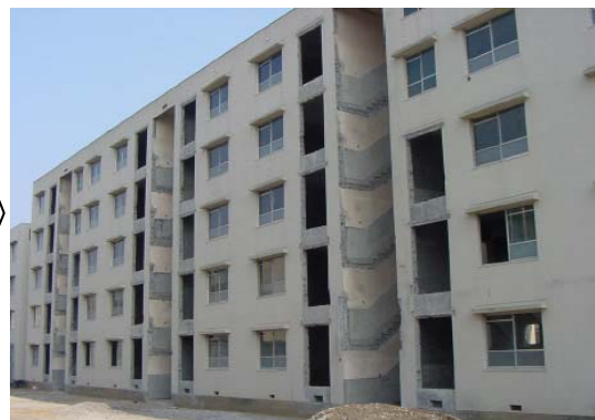
②階段室解体
