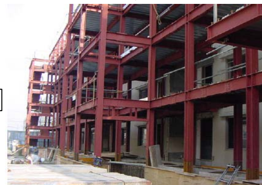
③廊下、階段、エレベータ新設
