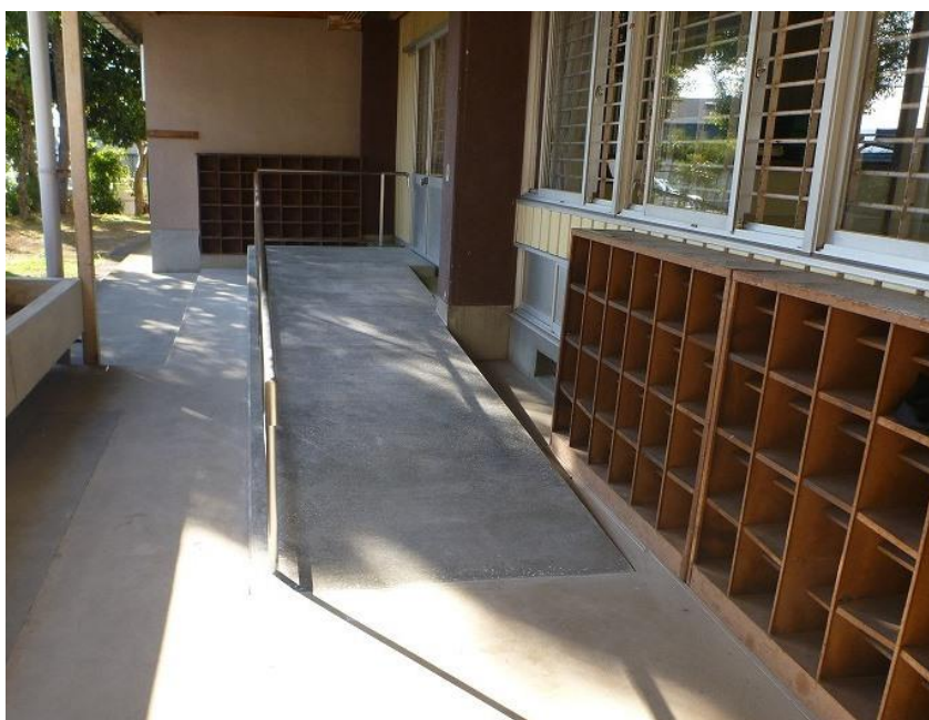
体育館入口にスロープを設置（山田小学校）
