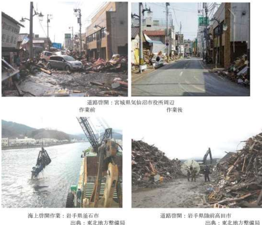
図 2.1 道路啓開状況
