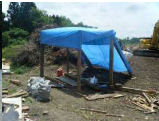
作業現場付近に設けられた休息所
