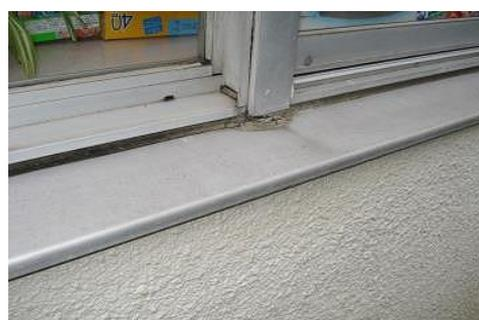
【C 判定】全体的に腐食・損壊がある、開閉不良がある、窓に亀裂がある
