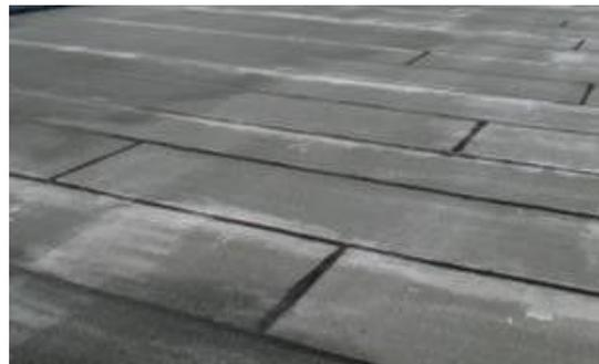
【C判定】広範囲に、ひび割れ、変質(摩耗)、破れ、下地露出がある
