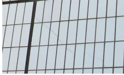
【C 判定】広範囲に、剥落、爆裂、幅広のひび割れがある。
