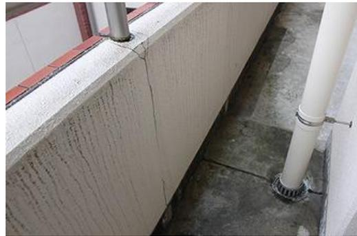
【C 判定】広範囲に、ひび割れ、鉄筋露出、さび汁、欠落がある
