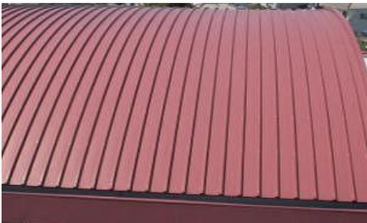
【B 判定】部分的に、塗装のはがれ、さび、変質、取付金物のさびがある。
