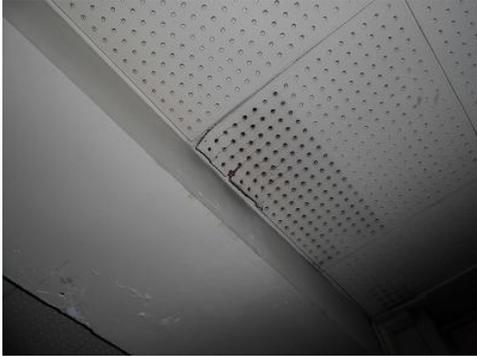
状況：浮き・破損がある
