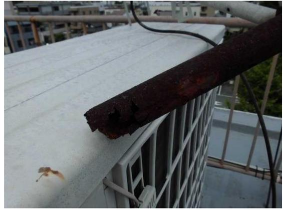
※アンテナ等が落下すると危険ですので、支柱の腐食に注意してください。
