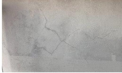
【C 判定】広範囲に、さび汁、ひび割れ、剥落、爆裂がある。
