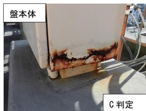
※屋外にある場合は、結露等により水滴が盤内に発生するので、水抜き穴があることを確認してください。
