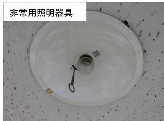
※誘導灯、非常用照明器具は、停電時にはバッテリーに切り替わります。点検用の引きひもやボタンを押し、点灯するか点検してください。
