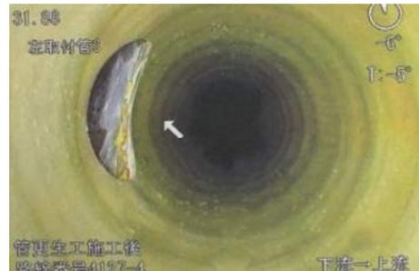
改築実施後（管の内側に樹脂を施工）
