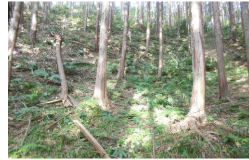
④ 斜面部の崩壊跡地 古い崩壊地で、植生があり、崩壊地の形状は留めていない。
