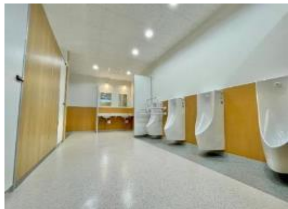
▲山田中学校（トイレ改修）
