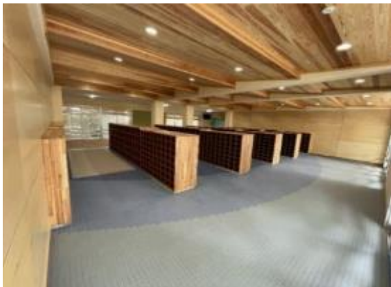
▲長伏小学校（昇降口改修）
