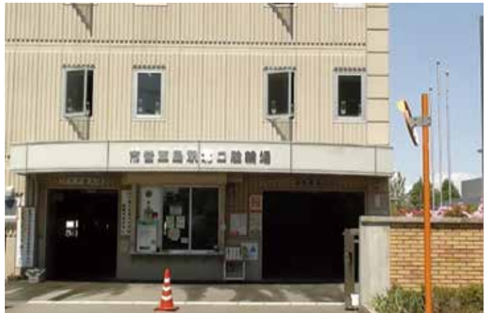
▼三島駅北口自転車等駐車場
