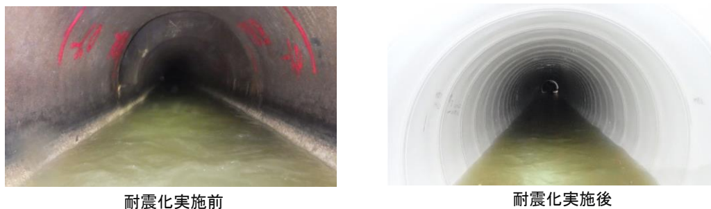
図 2-6 管路内部の耐震化状況
