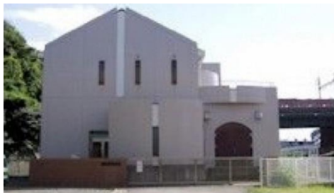
吉町田汚水中継ポンプ場（加茂川町）
