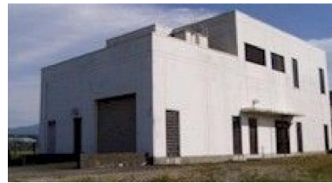
南部汚水中継ポンプ場（中）
