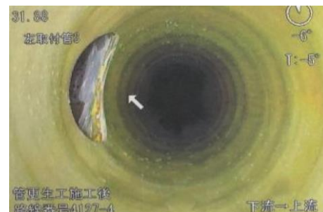
改築実施後（管の内側に樹脂を施工）
